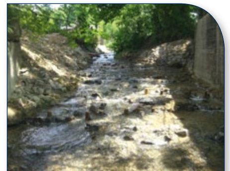
Die Sohlgleite in der Linnenbeeke gleicht den Höhenunterschied der einzelnen Stufen aus.
