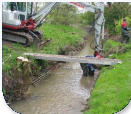
An der Großen Aue wurden die Rasengittersteine aus den Böschungen genommen, um die Bachsohle zu verbreitern und die Ufer abzuflachen.
