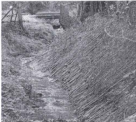
Geschützt: Matten aus Weidenruten sorgen dafür, dass die Böschung nicht wieder abrutscht.
