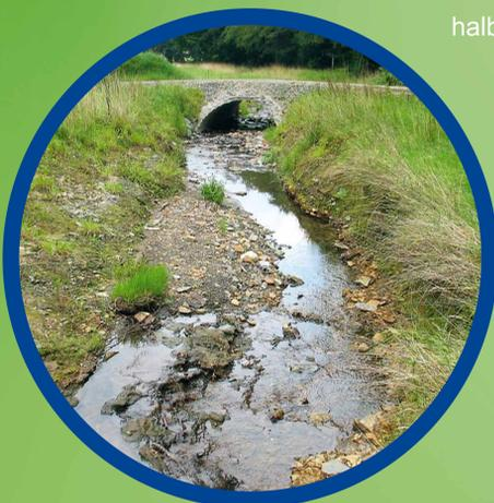
Ein Blick in den umgestalteten Bachabschnitt: Die zuvor viel zu enge Überfahrt wurde durch ein breites „Hamco-Profil“ ersetzt. Der Einbau erfolgte so tief, dass die Sohle dauerhaft mit einer Auflage natürlicher Bachsubstrate bedeckt ist: Kein Problem mehr für die Wanderungen der Bachbewohner!
