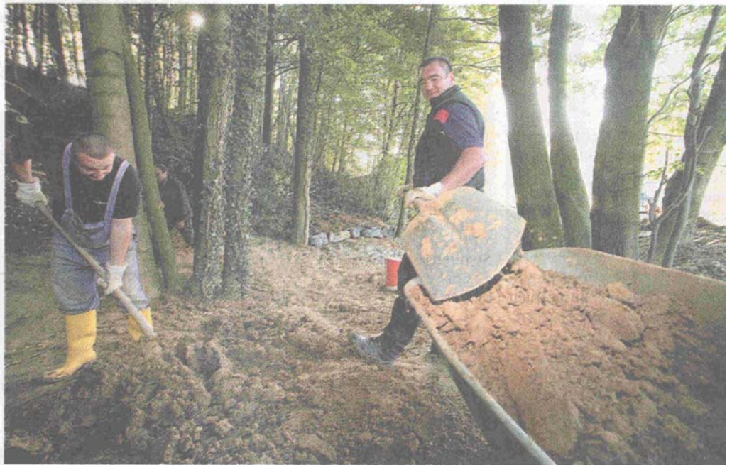
Arbeitsplätze schaffen: Vitali Selesinski (l.) und Viktor Schäfer schaufeln Lehm für den Damm, der den Bach in seinem Verlauf halten soll.
