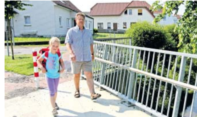
Trockenen Fußes über den Bach: Die neue Brücke ist nur noch für Fußgänger zugelassen. Über die alte Brücke durften auch Autos fahren.
