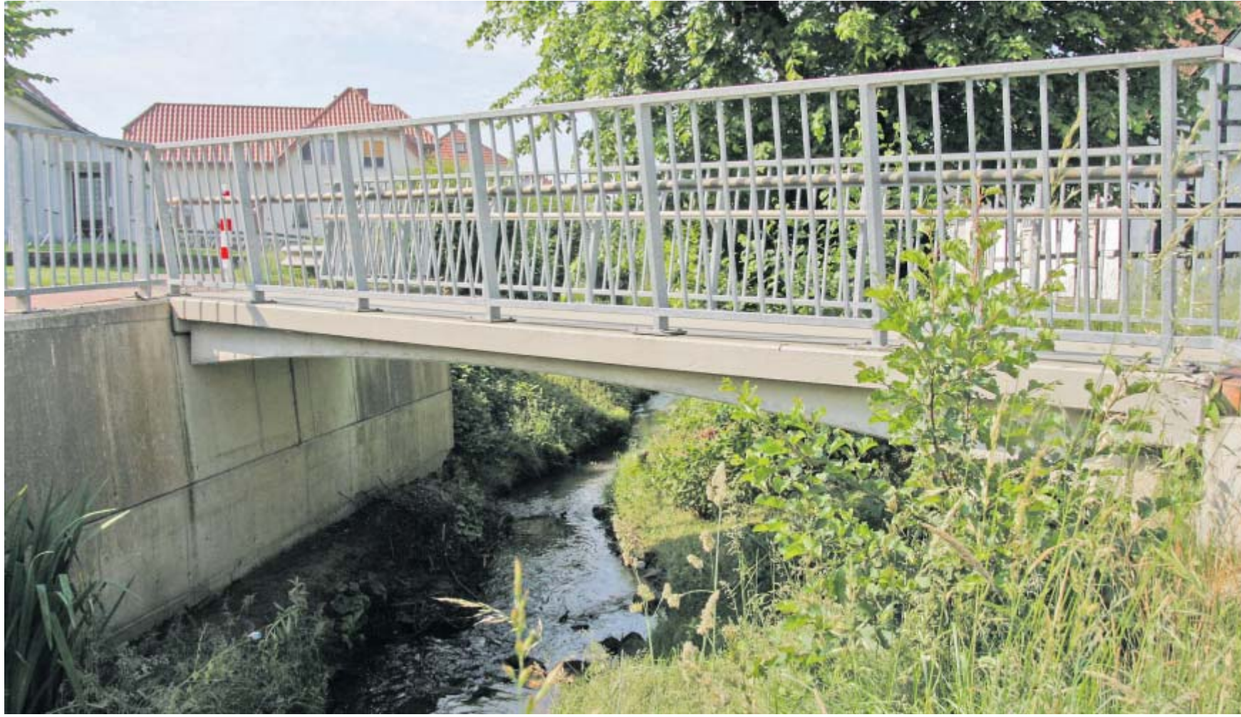
Neue Brücke gebaut: 2012 wurde die Fußgängerbrücke über den Tengerner Bach fertig. Die alte Brücke wurde 2011 abgerissen. Der Durchlass war wesentlich geringer, was zu seinem Anstau des Wassers führte.
