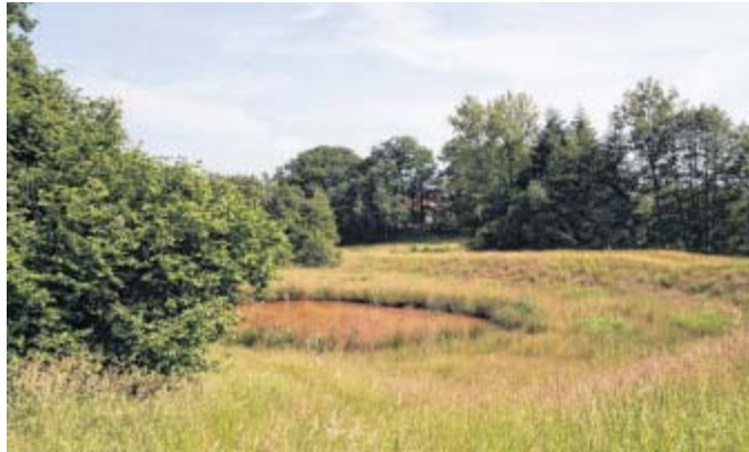
Naturnah gestaltet: Das Regenrückhaltebecken in Kümmerdingsen fasst 30.000 Kubikmeter Wasser. Der Erdwall ist drei Meter hoch.
