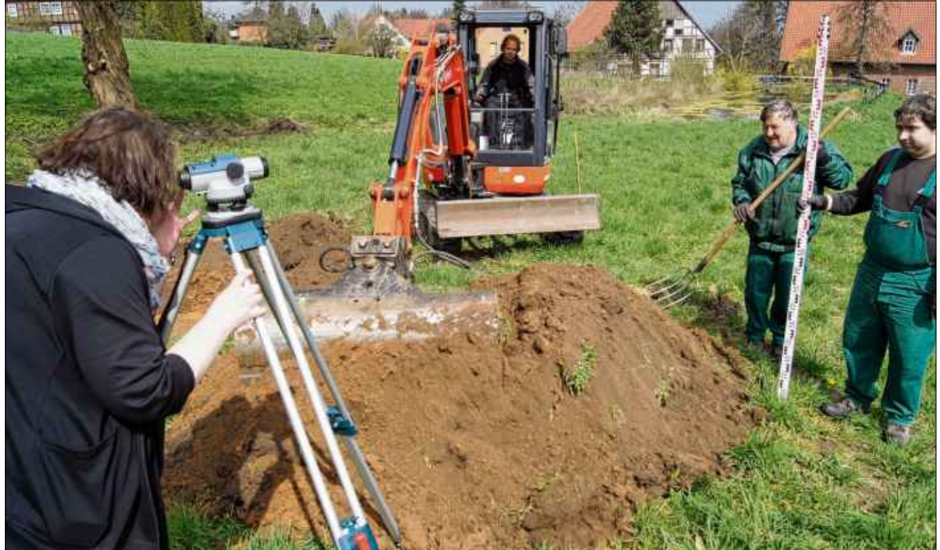
Mit dem Nivelliergerät (l.) werden Höhenunterschiede gemessen, während ein Kompaktbagger und mehrere Arbeiter im Einsatz sind. Im Hintergrund sind der Mühlenteich sowie beide Gebäude von Hartings Mühle zu erkennen. Foto: Stefan Lyrath
