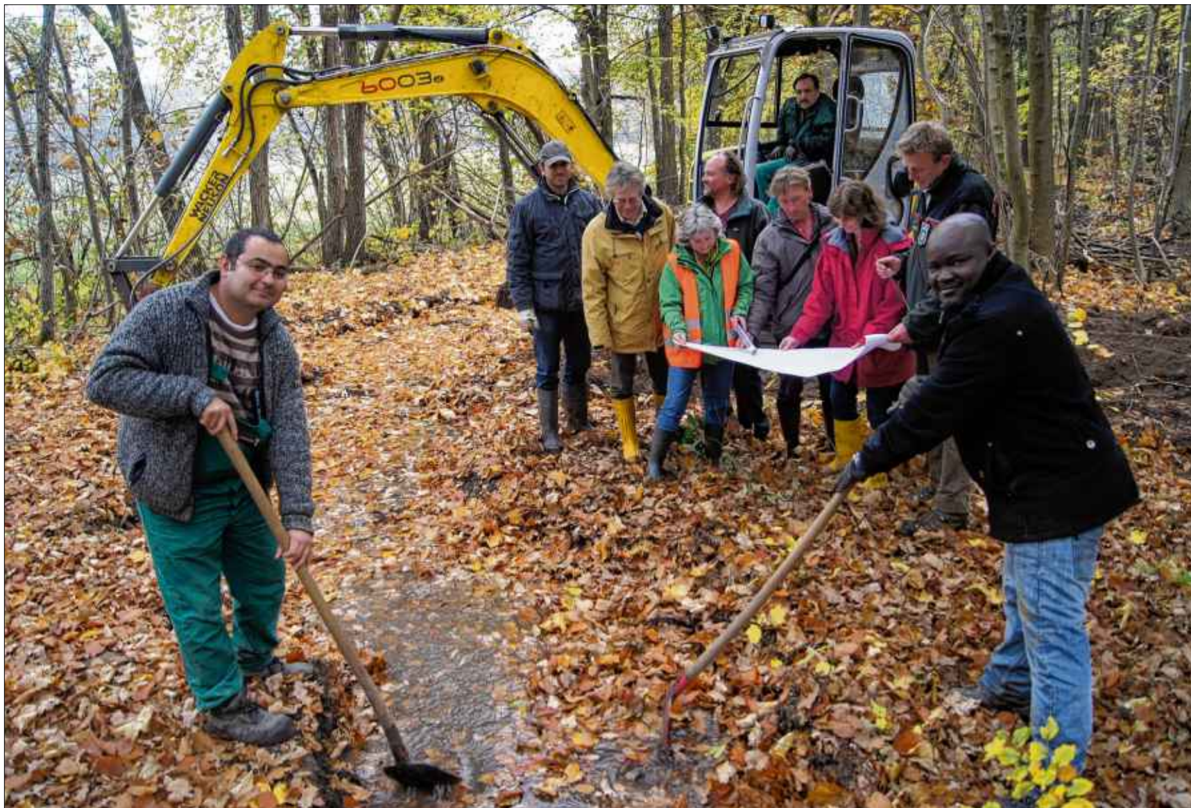
Zügig schreiten die Arbeiten zur Renaturierung in Nammen voran. Verantwortliche von Kreis, Stadt und Regionalforstamt machen sich im Unternammerholz ein Bild. Foto: Stefan Lyrath
