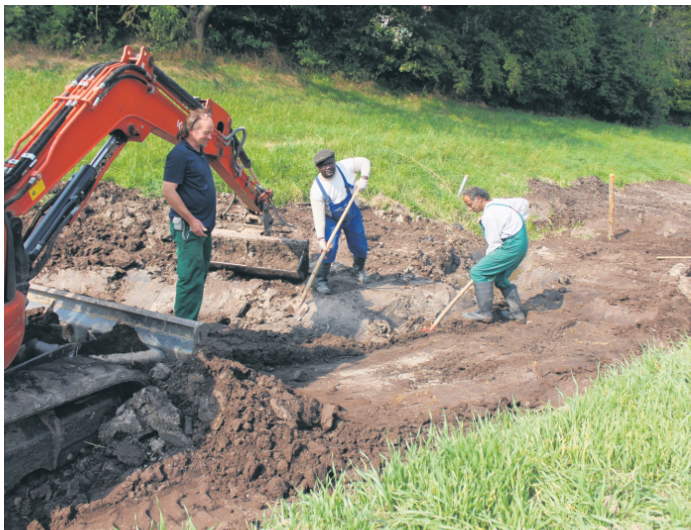
Handarbeit: Nachdem Jürgen Scharper (links) mit dem Bagger den groben Verlauf ausgehoben hat, machen sich Waseiu Lasi (Mitte) und Sahlah Zreikat an die Feinarbeit.
