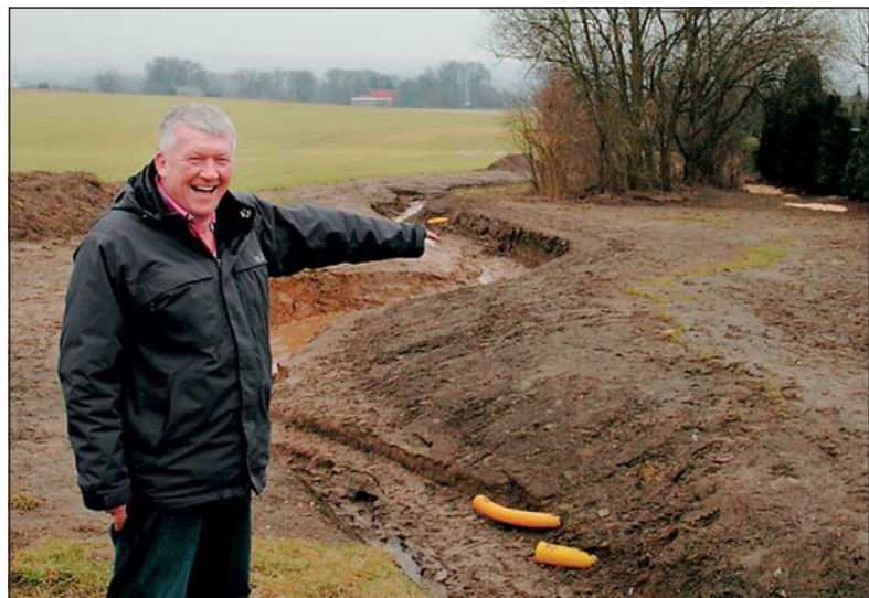
Nahe der Bergkirchener Straße ist der Siemshofer Bach renaturiert worden – zur Freude von Projektleiter Ralf Isemann. Fotos: Berning
