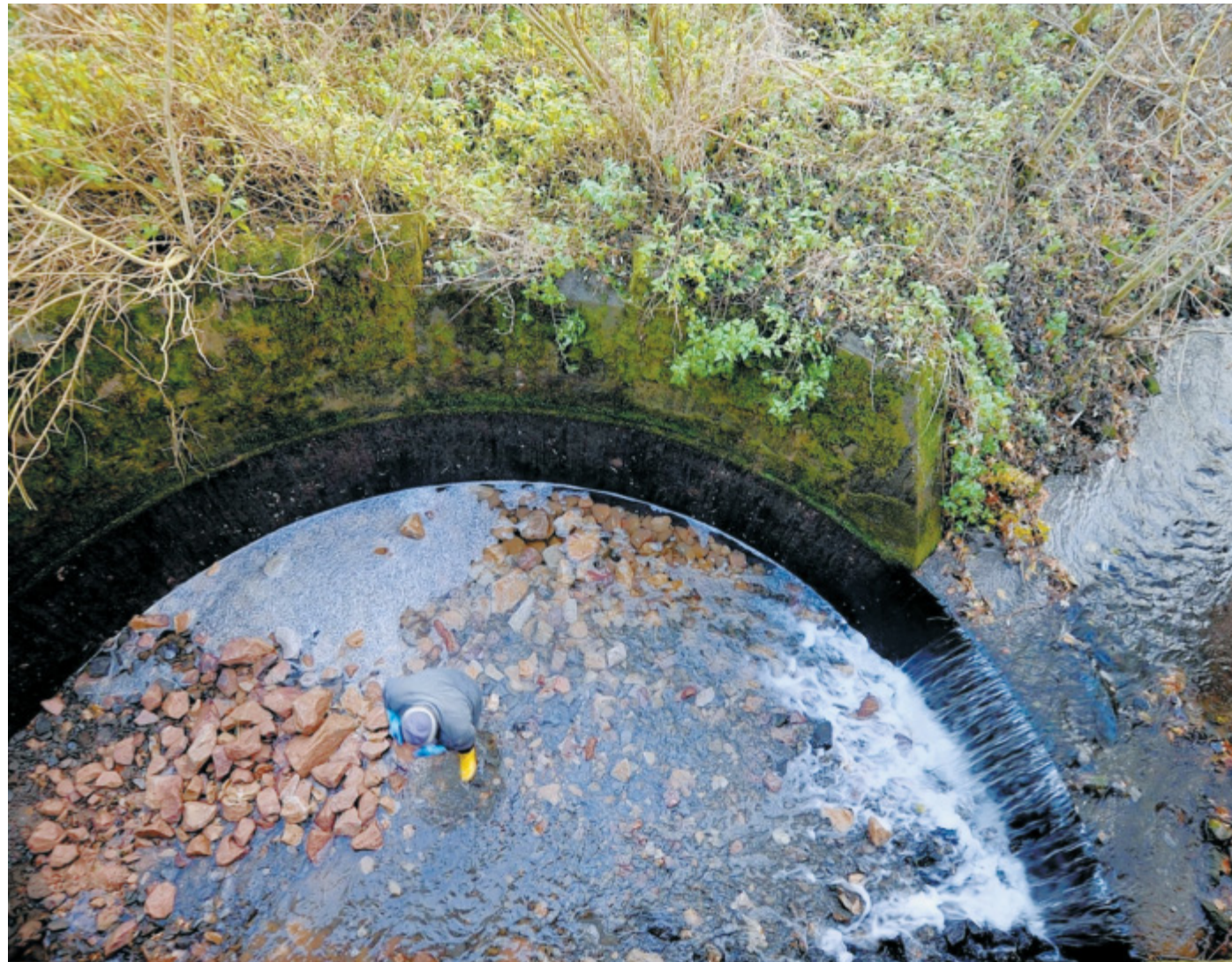
Stein auf Stein: Vorarbeiter Alexander Garvart legt die Steine in dem Tosbecken des Brandbaches von Hand so aufeinander, dass auch Hochwasser die Steine nicht wegschütten kann.
