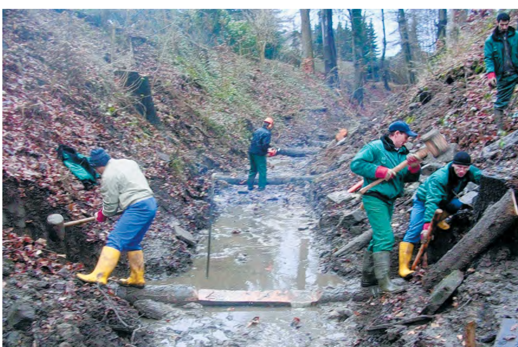
Handarbeit: Die Mitarbeiter des Weser-Werre-Else-Projektes befestigen die Bachufer in der Oeynhausener Schweiz.
