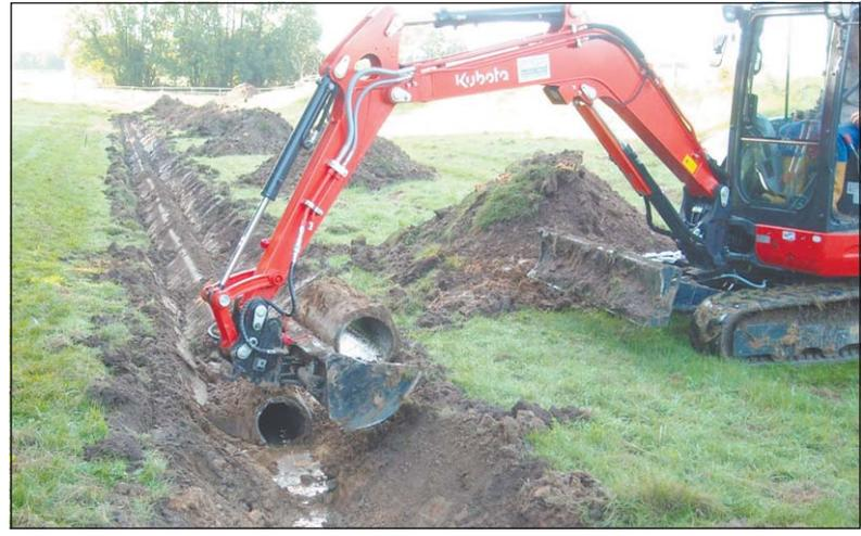
Damit der Bach wieder überirdisch fließen kann, mussten zunächst die unterirdischen Betonrohre entfernt werden. Foto: BZ
