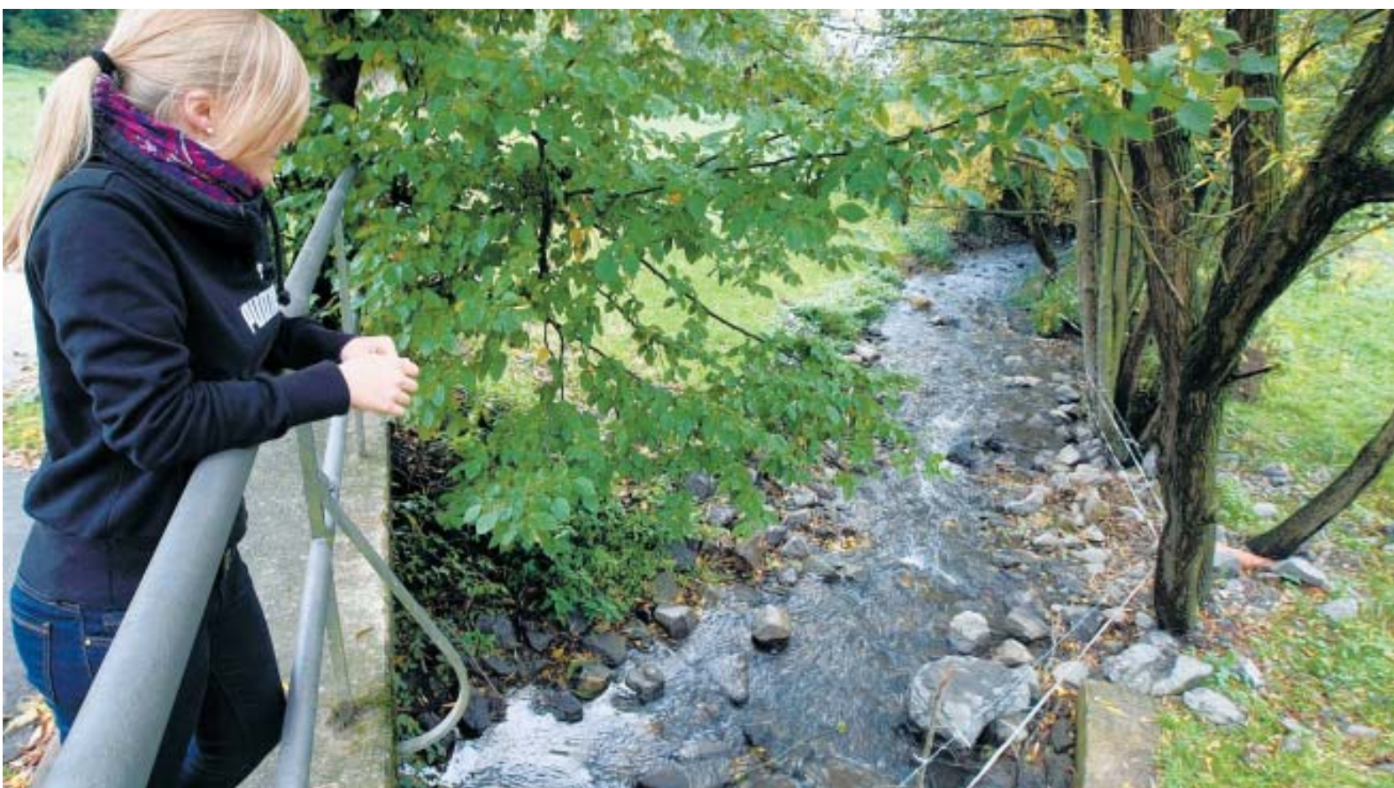
Starkes Gefälle entschärft: Kristin Potthoff (15) blickt von der Brücke am Herzogweg auf die Sohlgleite, die den Ostbach an dieser Stelle für Fische wieder passierbar macht.
