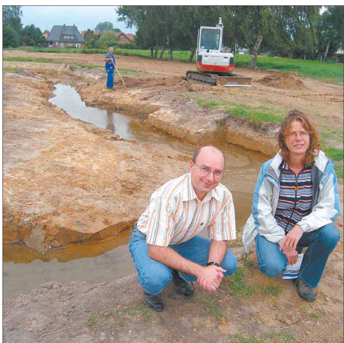
Klaus Hagemeyer und Carola Fürste vor dem neuen Verlauf des Gestringer Baches. Sie hoffen, dass sich durch die Renaturierung neue Tier- und Insektenarten in Gestringen ansiedeln. Foto: Felix Quebbemann
