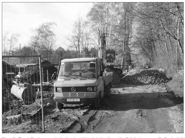
Eine Großbaustelle ist am Haubach eingerichtet sind umfangreiche Erdarbeiten notwendig. Der Aushub worden, wo ein Regenrückhaltebecken entsteht. Dafür wird an anderer Stelle benötigt.
