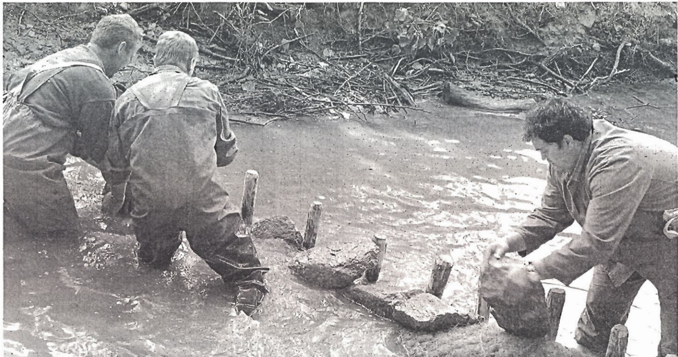
Knochenarbeit: Mit Steinen verstärkte Dämme leiten die Linnenbeeke wieder zurück in das historische Flussbett.
