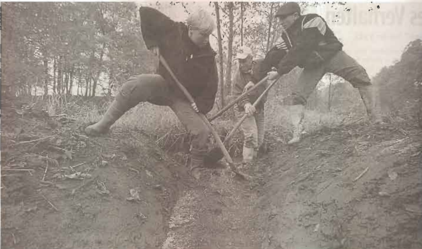
Durchstich: Janet Gaßtdorf, Hetem Osmani und Bekem Banowice (Foto v.l.) von der Initiative „Maßarbeit“ leiten den Gewinghauser Bach in das von ihnen gegrabene Bachbett im Siek am Habighorster Weg. Das begradigte Stück unweit davon, wo Bach lange Zeit floss, wird stillgelegt.
