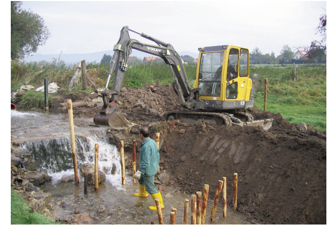
Abriss eines Wehres und Bau einer Sohlgleite
